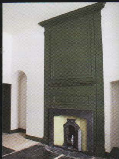
▲ Ook de wanden met nissen naast deze schouw zijn volledig gespannen op tengels.
